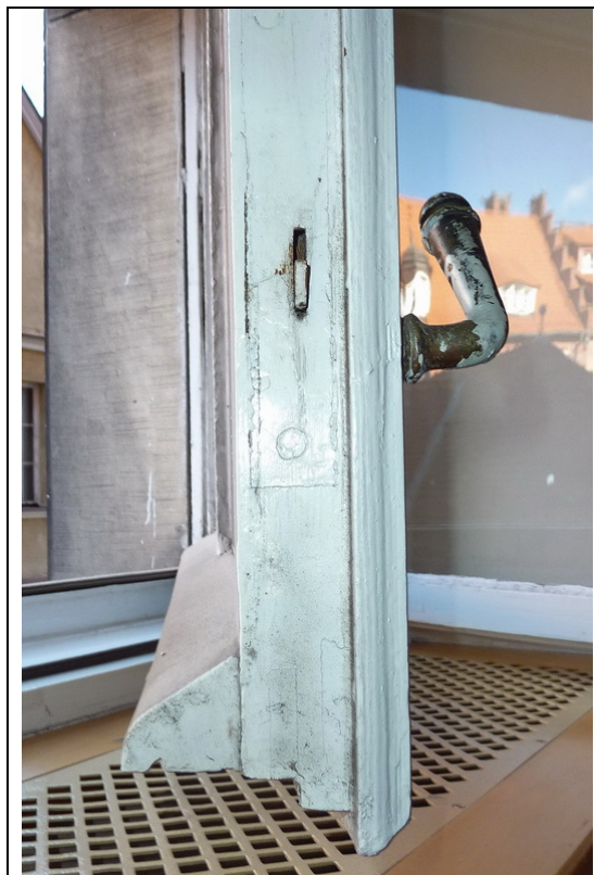
5. Detal zabytkowej zasuwnicy
