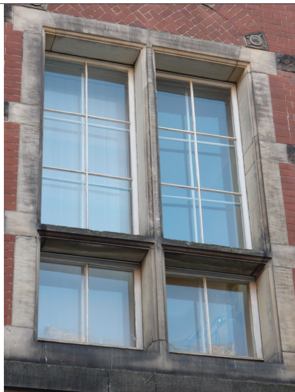
10. Okno zabytkowe od strony zewnętrznej
