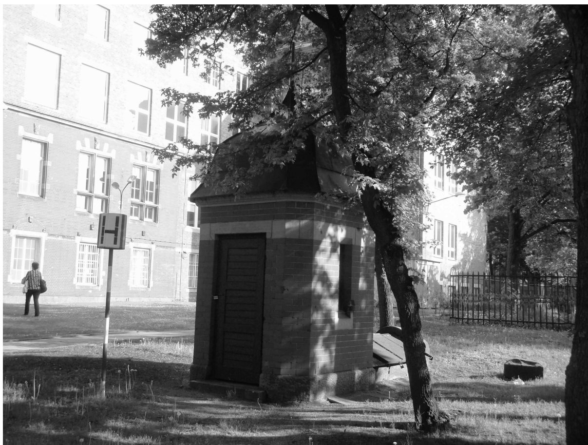
Rysunek 7. Widok na wejście do podziemnego kanału
