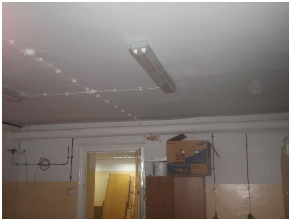
Rysunek 12. Widok sufitu w pomieszczeniu P 7
