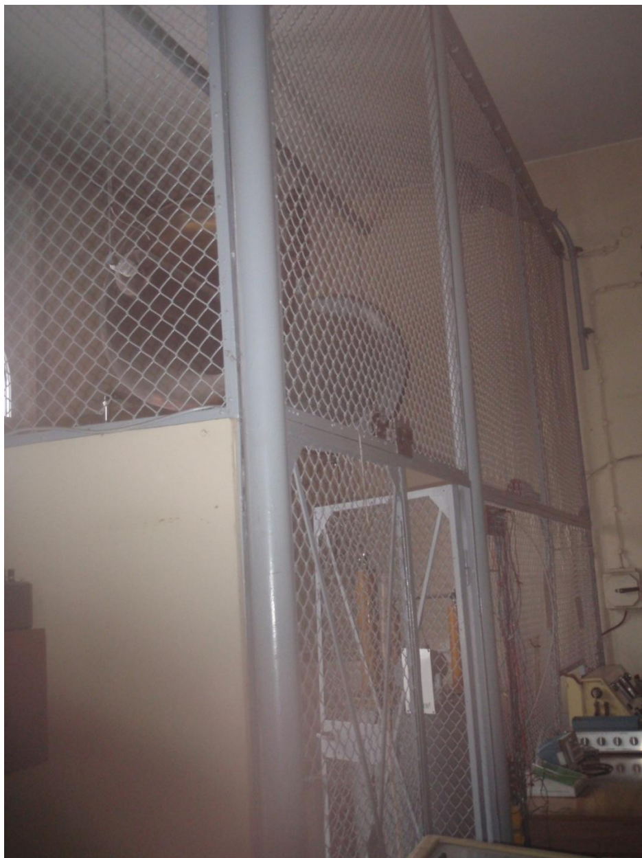
Rysunek 11. Wygradzenie we wnętrzu pomieszczenia WN 5
