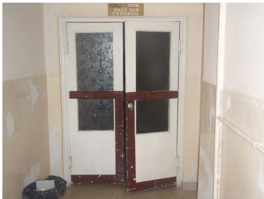
Rysunek 4. Widok drzwi wahadłowych na parterze
