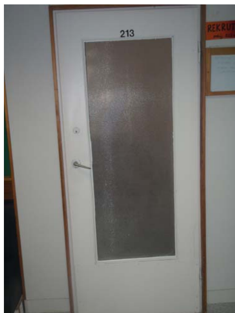
Rysunek 8. Widok drzwi w pomieszczeniu 213
