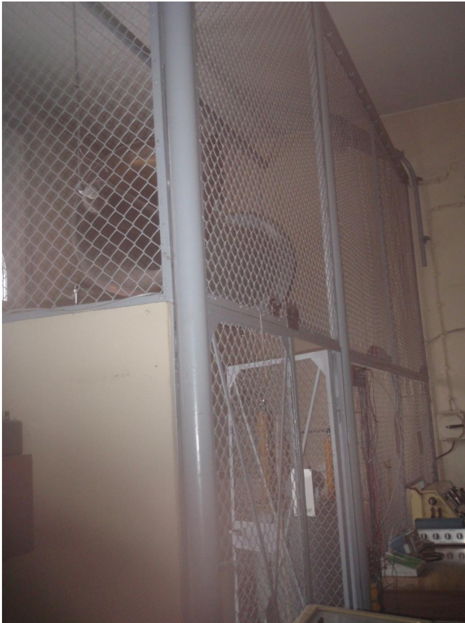
Rysunek 11. Wygradzenie we wnętrzu pomieszczenia WN 5
