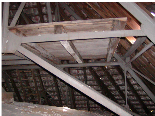
Il. 1 i 2 widok istniejącego drewnianego pomostu roboczego poddasza audytorium /zdj. autora/
