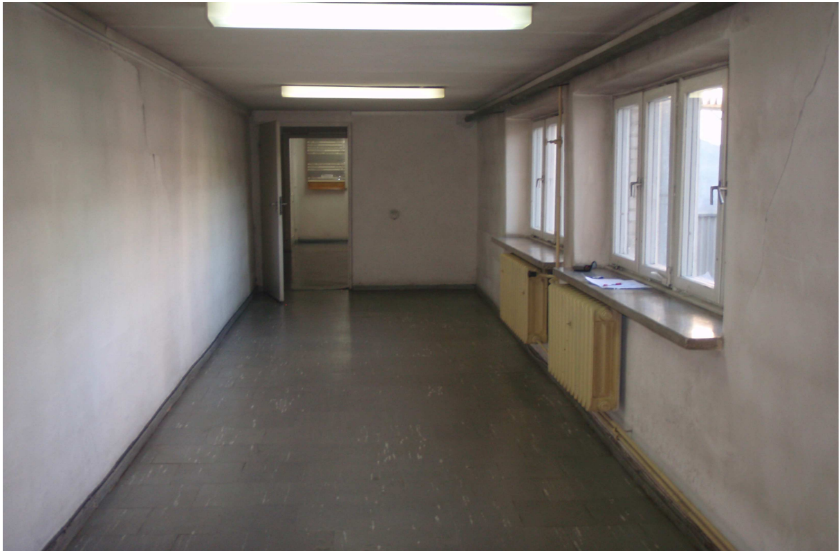
Rys. 6. Widok spękań łącznika-1
