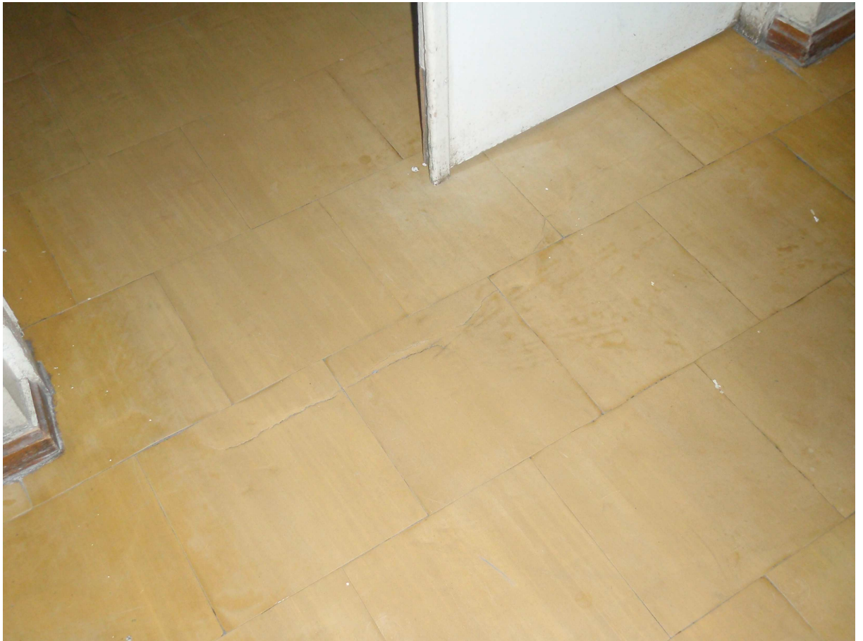
Rysunek 3. Spękanie posadzki na stropie
