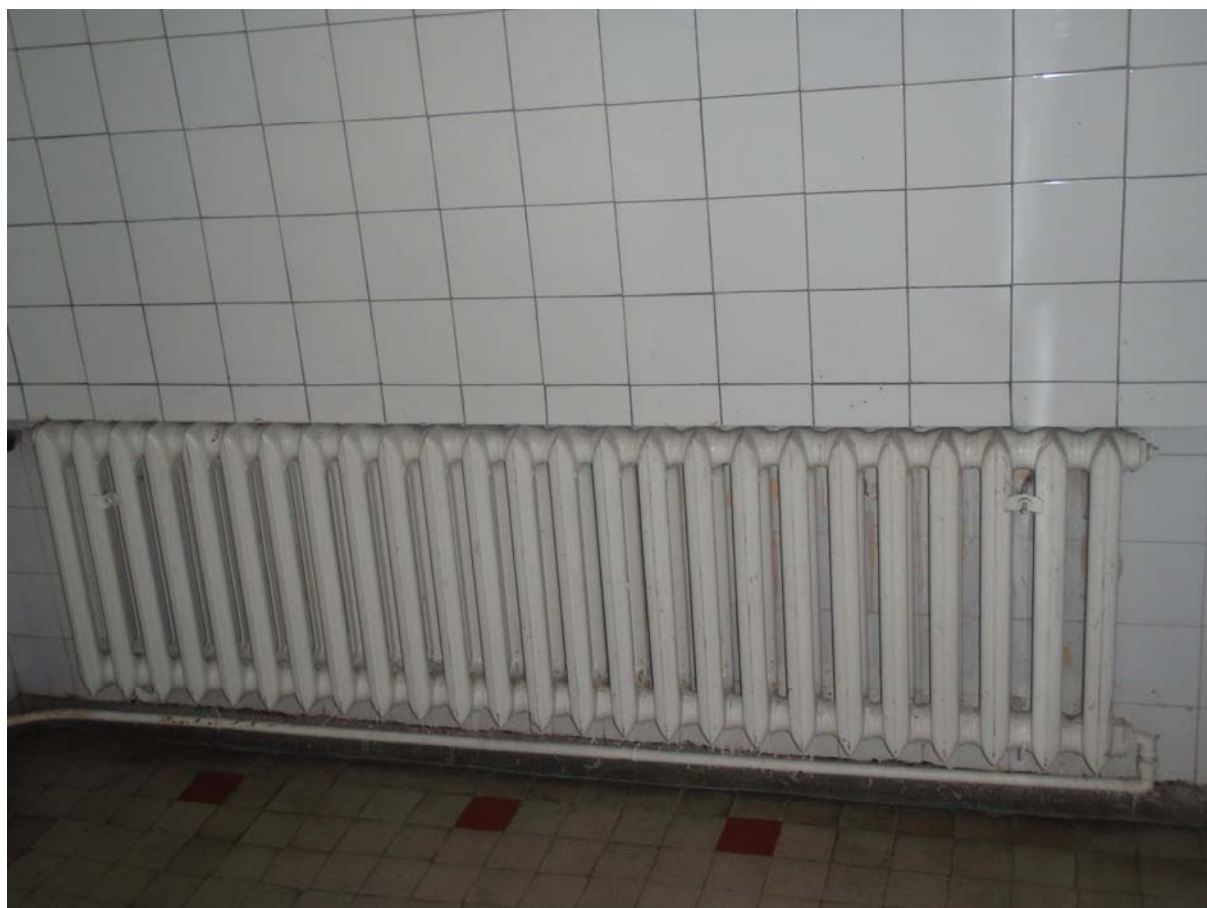
Rysunek 1. Widok grzejników w planowanych do remontu toaletach
