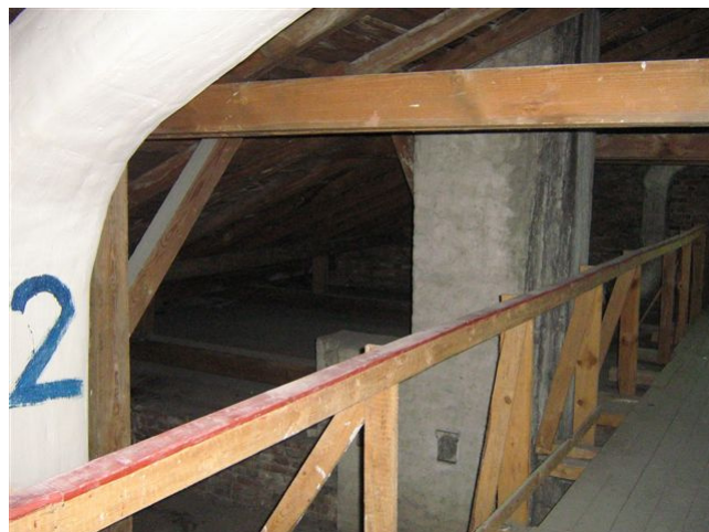
Dach/konstrukcja drewnianej więźby dachowej
