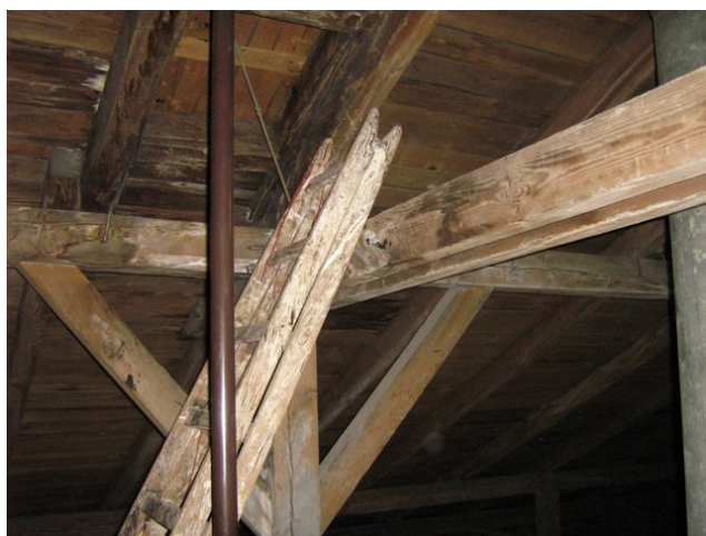
Dach/konstrukcja drewnianej więźby dachowej
