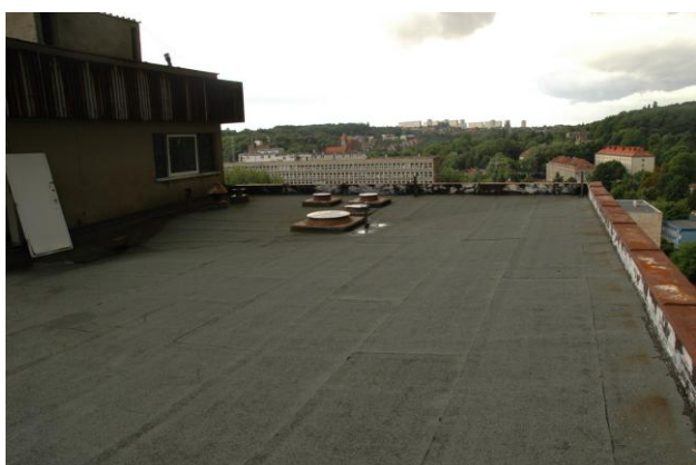
Dach/połać dachowa-budynek główny
