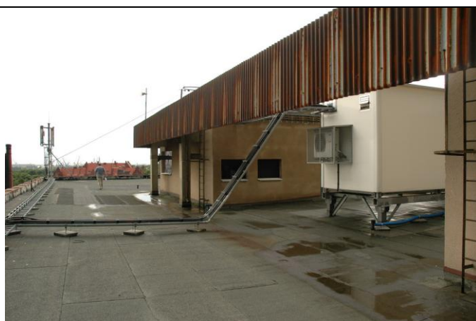
Dach/połać dachowa-budynek główny
