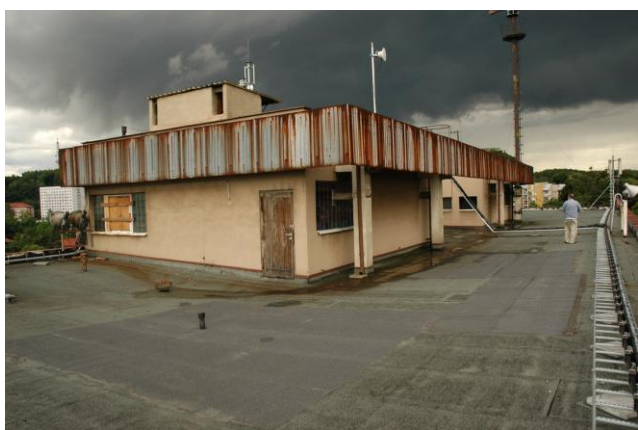
Dach/połać dachowa-budynek główny
