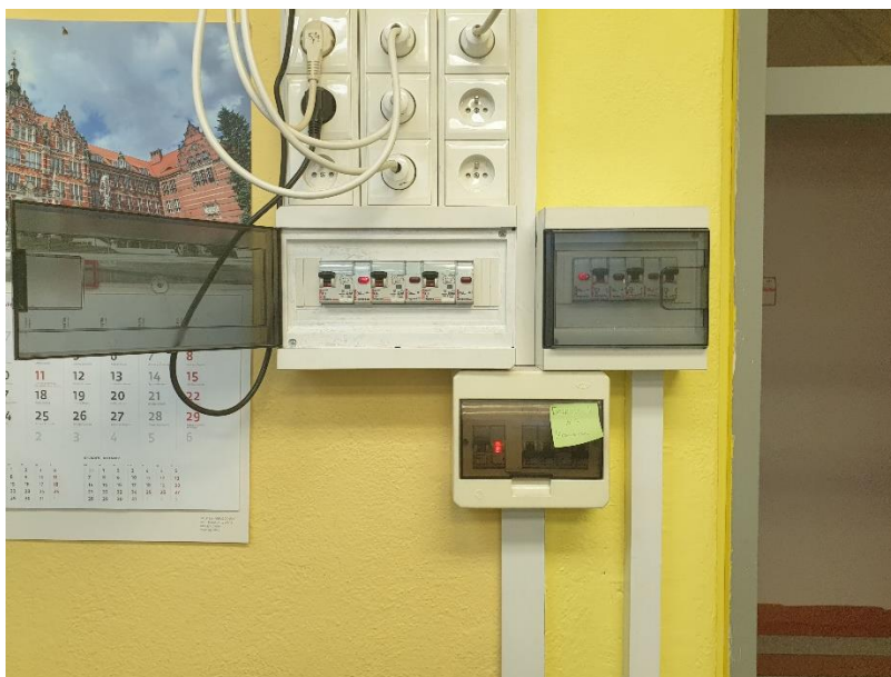
istniejące szafki elektryczne oraz gniazda natynkowe do demontażu
