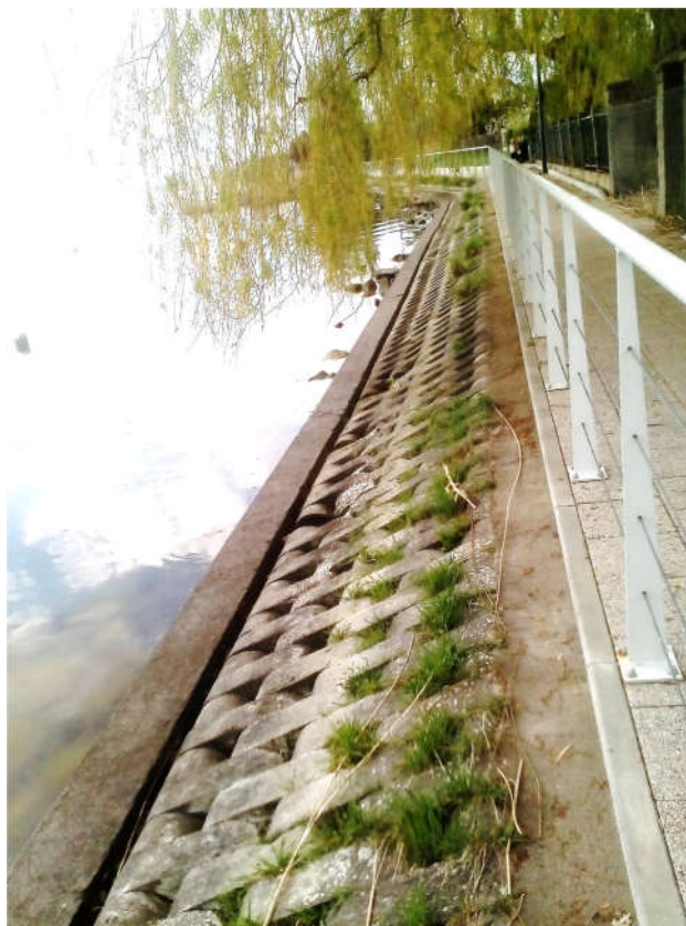
Fot. Widok umocnienia brzegowego Martwej Wisły na wysokości działki Inwestora (ciąg pieszo – rowerowy, łańcuch Galla, oczep palisady, narzut z kamienia).
