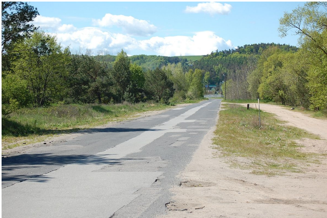
Rys. 1. Widok opisywanego fragmentu ulicy Spokojnej w kierunku południowo-zachodnim, tj. zgodnie z przyjętym kilometrażem roboczym.
