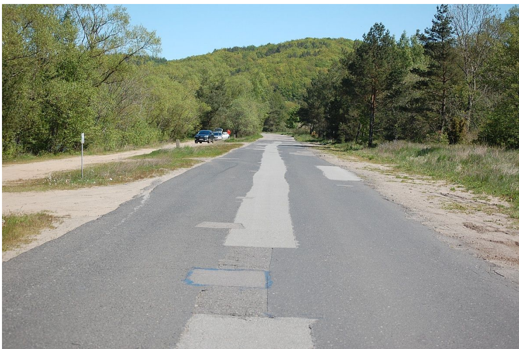
Rys. 2. Widok opisywanego fragmentu ulicy Spokojnej w kierunku północno-wschodnim, tj. przeciwnie do kierunku przyjętego kilometraża roboczego.
