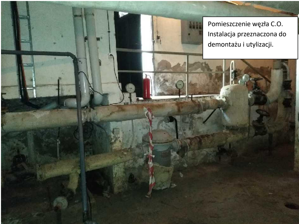
Pomieszczenie węzła C.O. Instalacja przeznaczona do demontażu i utylizacji.
