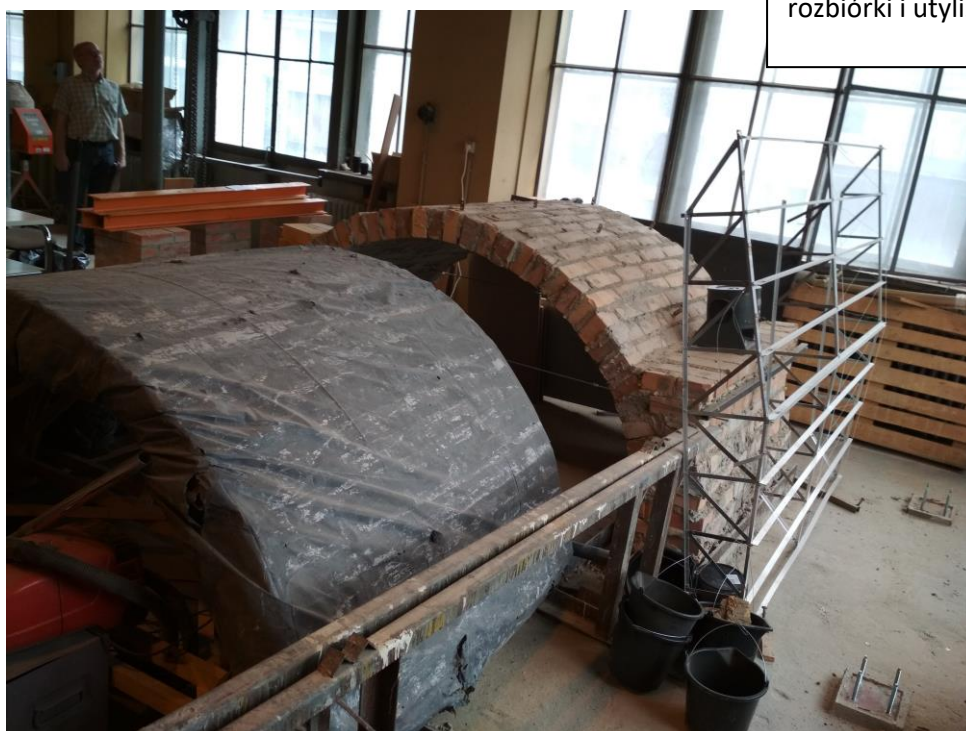
Elementy (łukowe) przeznaczony do rozbiórki i utylizacji.
