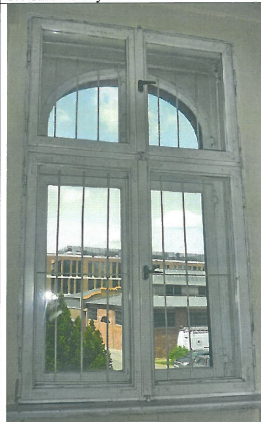
19. Okno O20 pierwotnie skrzynkowe z dostawioną kratą i wtórna konstrukcją od wnętrza.
