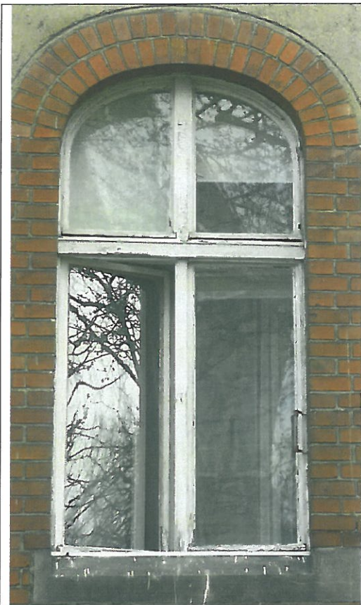
5. Okno skrzynkowe parteru w elewacji pd.
