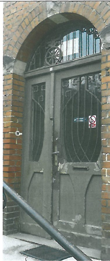
22. Zabytkowe drzwi zewnętrzne.
