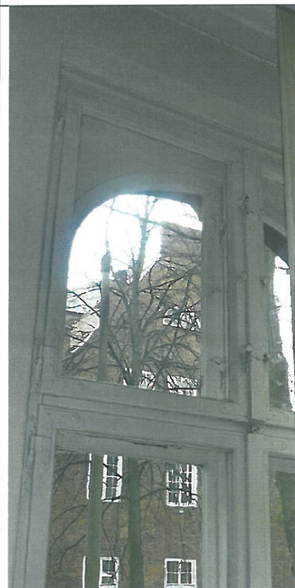
7. Okno skrzynkowe parteru od wnętrza.
