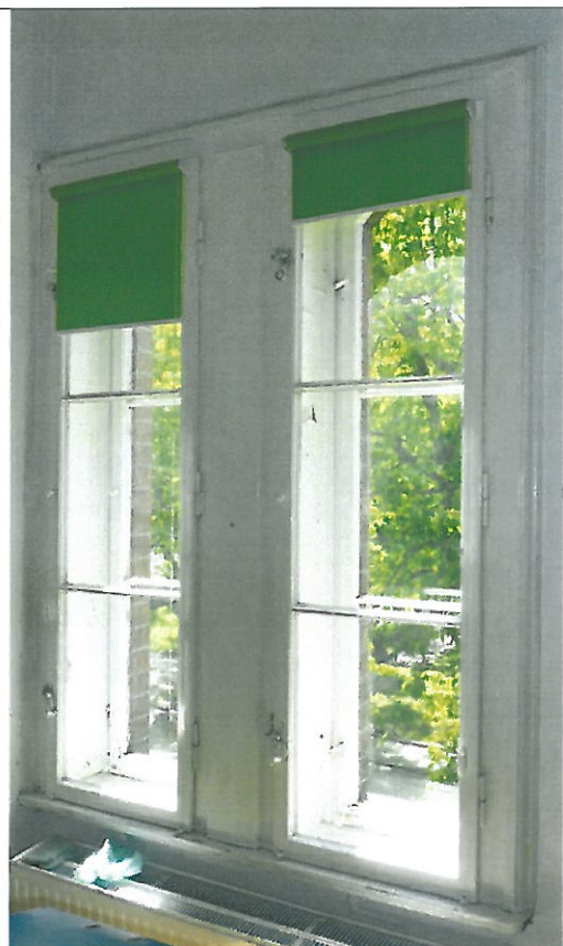
14. Okno pierwotnie pojedyncze z dostawionymi wtórnie skrzydłami – poddasze.
