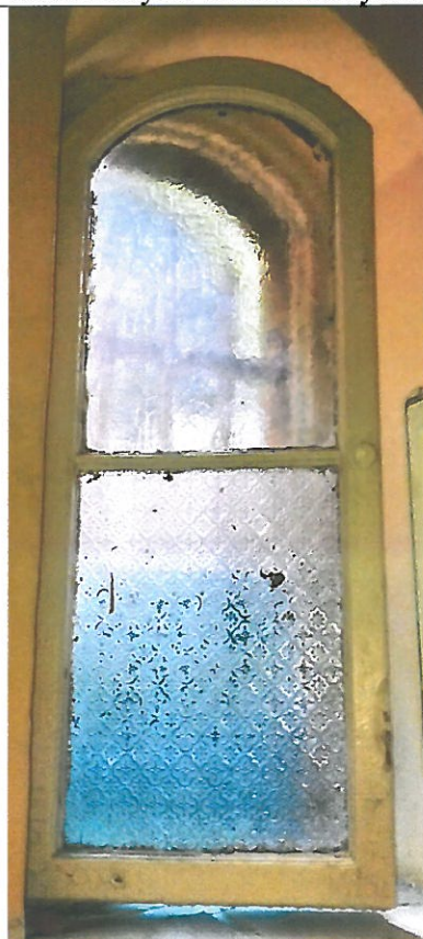
16. Zabytkowe okno pojedyncze w POM. WC na parterze.
