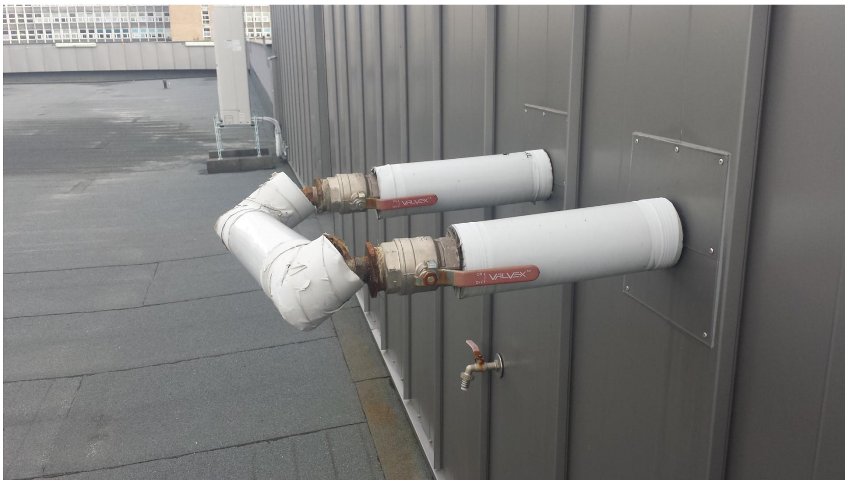
Rys. 3 Widok miejsca przyłączenia chłodnicy wentylatorowej CHW do istniejącego układu grzewczego laboratorium
