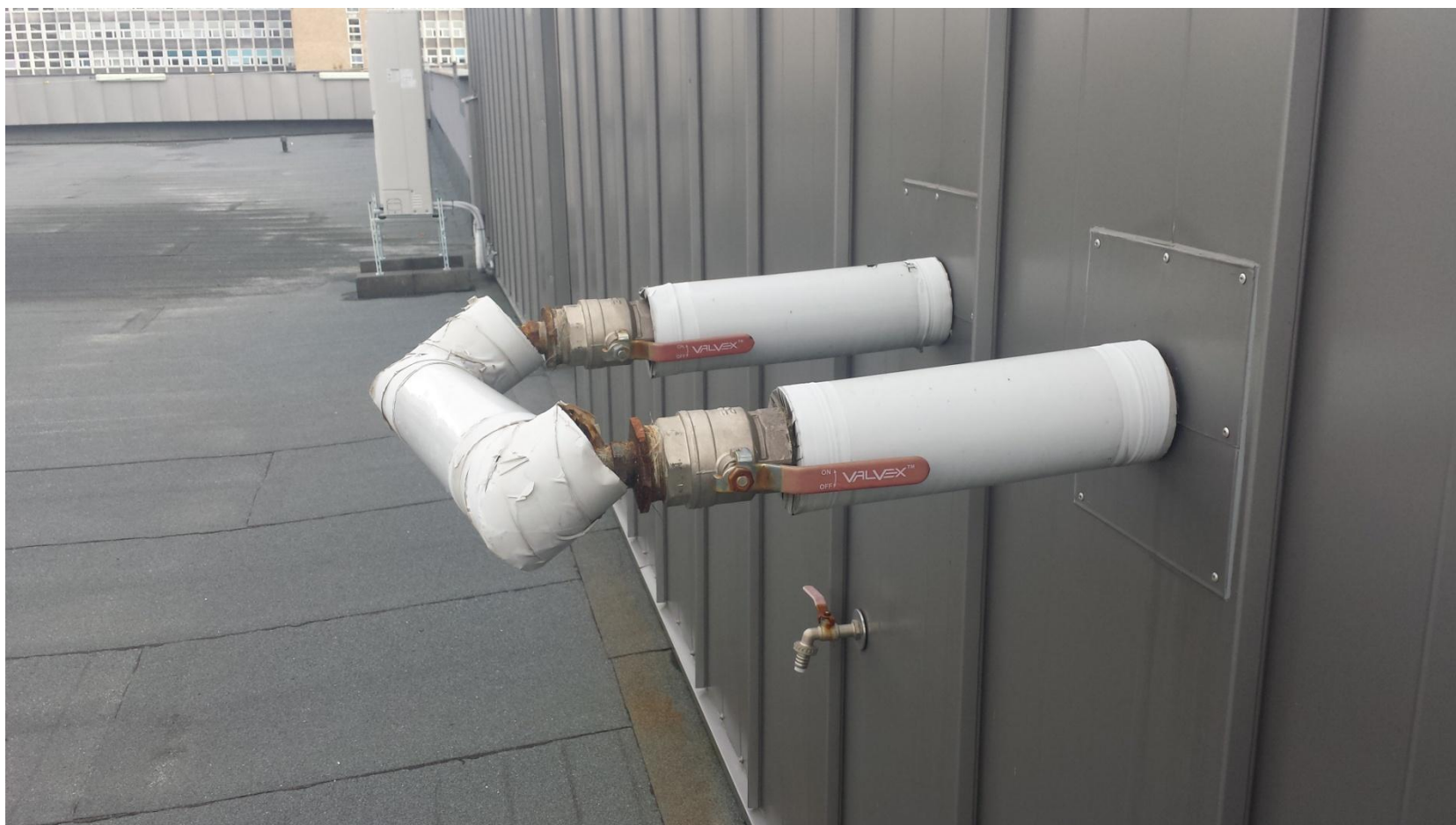
Rys. 9 Widok miejsca przyłączenia chłodnicy wentylatorowej CHW do istniejącego układu grzewczego laboratorium
