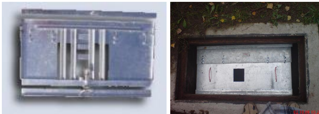
Rys. 2 Wewnętrzne zabezpieczenie studni.
