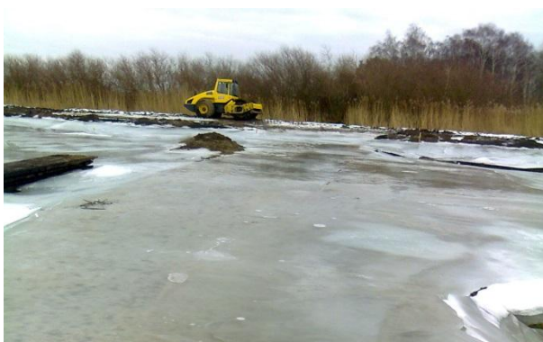
Fig. 10. Frozen construction site 02-2014
