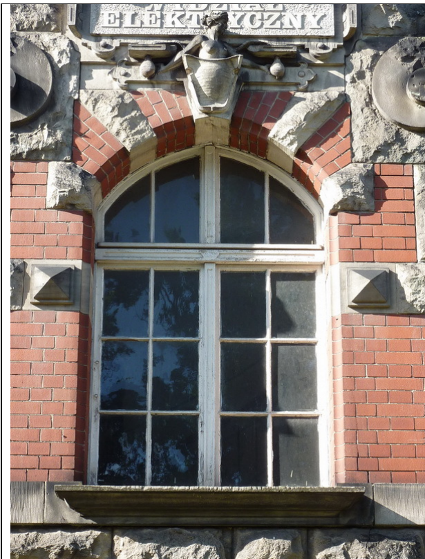
1. Zabytkowe okno w elewacji z dekoracyjnym słupkiem i ślemieniem.
