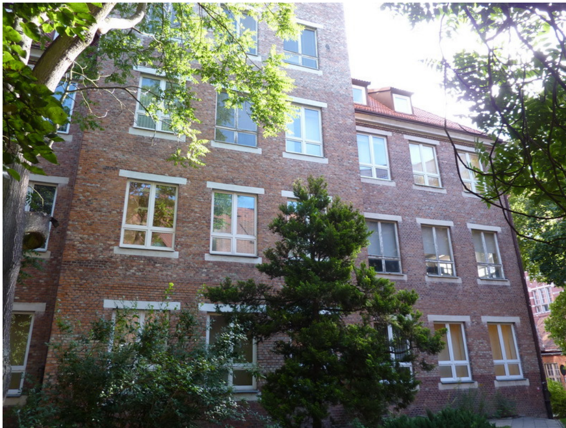
Elewacja nowego skrzydła z oknami drewnianymi przeznaczonymi do wymiany oraz oknami PVC.
