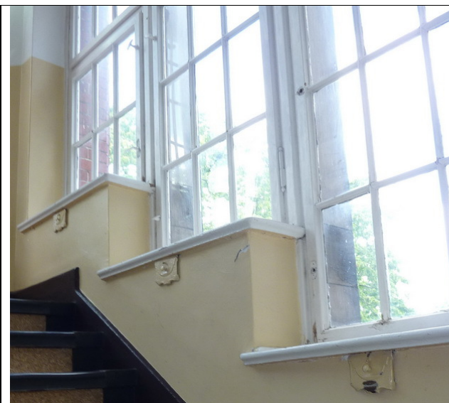
9. Pojedyncze okna na klatce schodowej.
