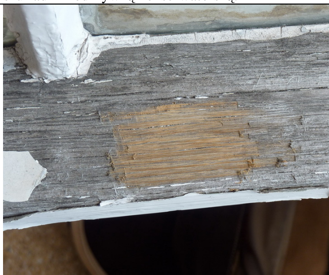
12. Odkrywka konserwatorska na okapniku okna. Widoczny gatunek drewna - dębina.
