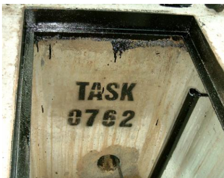
Rys. 6 Wygląd malowania numeru wewnątrz studni TASK.
