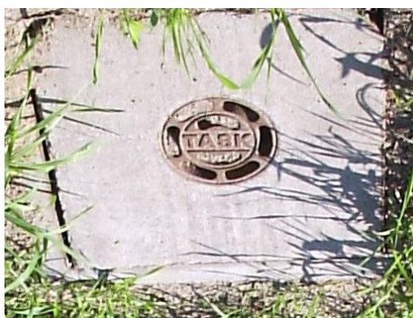
Rys. 5 Wygląd wietrznika nakrywy.
