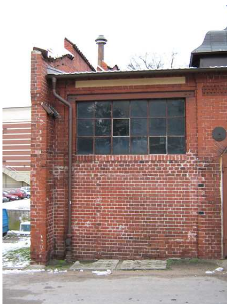
10. i 11. Fragmenty elewacji południowej – okna stalowe z niejednorodnym wypełnieniem, zamalowania, zabrudzenia zaprawą, niejednorodne spoinowanie, ubytki cegieł.
