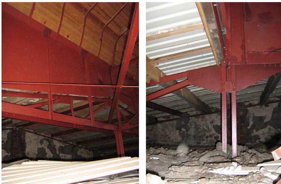
24. i 25. Konstrukcja stalowa wsporcza latarni i dachu. stan techniczny dobry. Widoczna blacha zamykająca latarnię oraz fragmenty deskowania hełmu.
