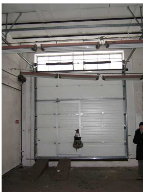
5. i 6. Brama segmentowa i wrota drewniane w elewacji wschodniej w widoku od wewnątrz.
