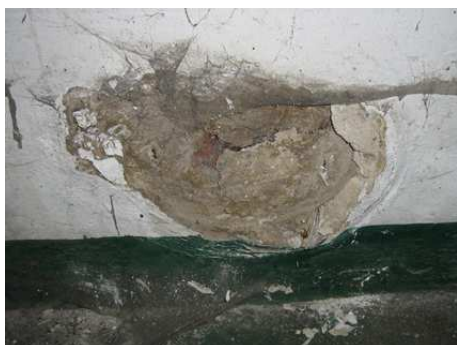
22. i 23. Ubytki tynku wewnętrznego w pasie ponad posadzką w ścianie północnej, widoczne zawilgocenie muru.
