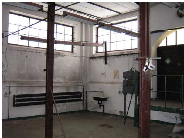
20. i 21 Narożnik południowo-wschodni budynku - widoczne stalowe słupy, ściagi, rampa oraz zawilgocenia poniżej kaloryfera i ubytek tynku w ścianie południowej.
