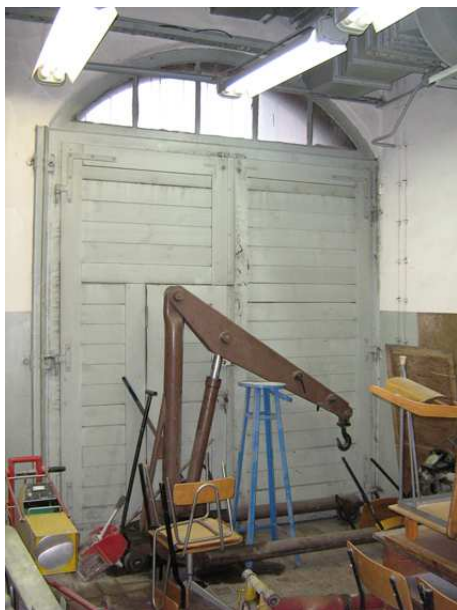
19. Wrota drewniane elewacji północnej od wewnątrz.
