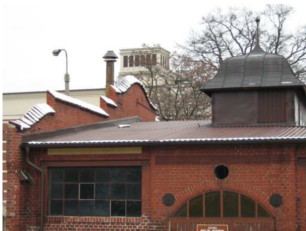
12. i 13. Dachówka mnich-mniszka na attyce ściany zachodniej, okna latarni, blacha trapezowa przykrywająca okno latarni, obróbka blacharska dachu przy attyce.
