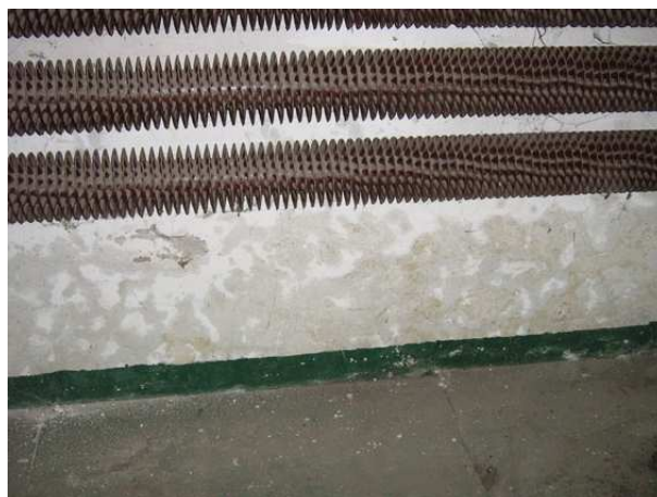
20. i 21 Narożnik południowo-wschodni budynku - widoczne stalowe słupy, ściagi, rampa oraz zawilgocenia poniżej kaloryfera i ubytek tynku w ścianie południowej.
