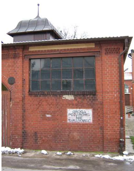
10. i 11. Fragmenty elewacji południowej – okna stalowe z niejednorodnym wypełnieniem, zamalowania, zabrudzenia zaprawą, niejednorodne spoinowanie, ubytki cegieł.
