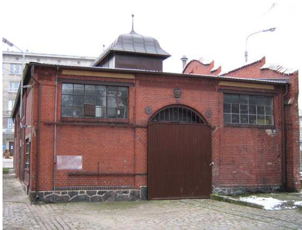
16. Elewacja północna – wrota stalowe przesuwne przesłaniające oryginalne, ubytki cegieł, zamalowania, okna stalowe z niejednorodnym wypełnieniem, czerpnia powietrza w oknie.
