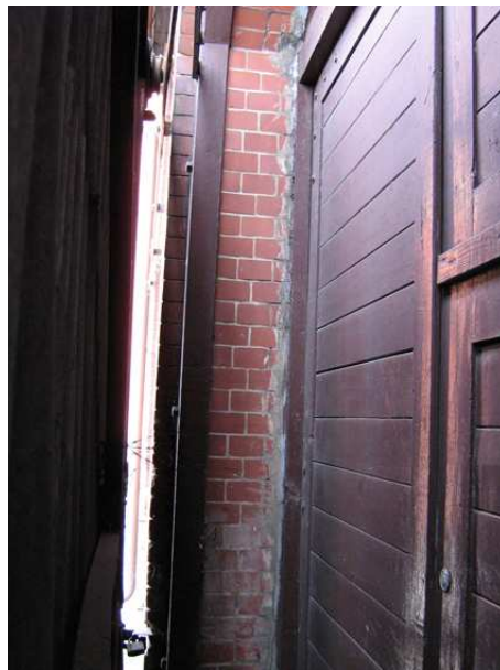
16. Elewacja północna – wrota stalowe przesuwne przesłaniające oryginalne, ubytki cegieł, zamalowania, okna stalowe z niejednorodnym wypełnieniem, czerpnia powietrza w oknie.
