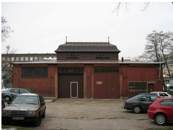
4. Elewacja wschodnia – brama segmentowa i wrota drewniane.
