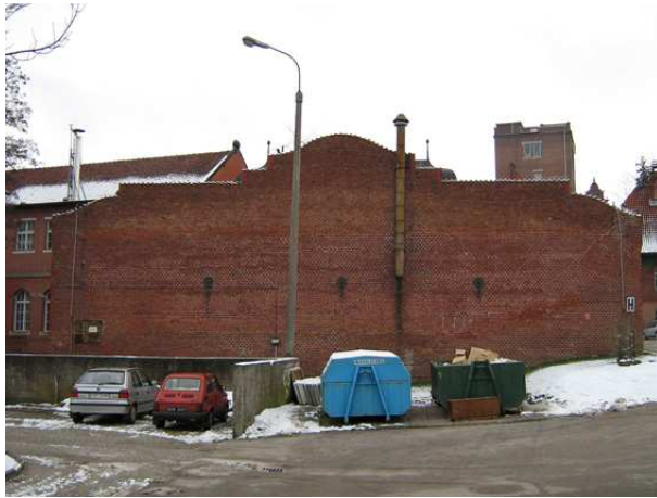
14. i 15. Elewacja zachodnia – zacieki pod stalowymi zakotwieniami ściągów i przewodu wentylacyjnego. Szczegół zakotwienia.
