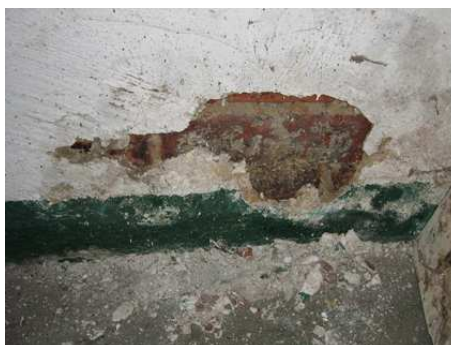
22. i 23. Ubytki tynku wewnętrznego w pasie ponad posadzką w ścianie północnej, widoczne zawilgocenie muru.
