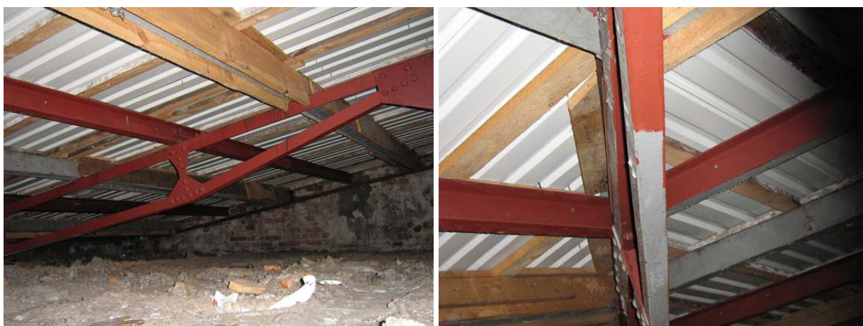
26. i 27. Konstrukcja stalowa dachu – kratownice oraz płatwie stalowe ceowe i wymienione na drewniane – dobry stan techniczny. Połączenie dachu z blachy trapezowej na łąkach drewnianych.
