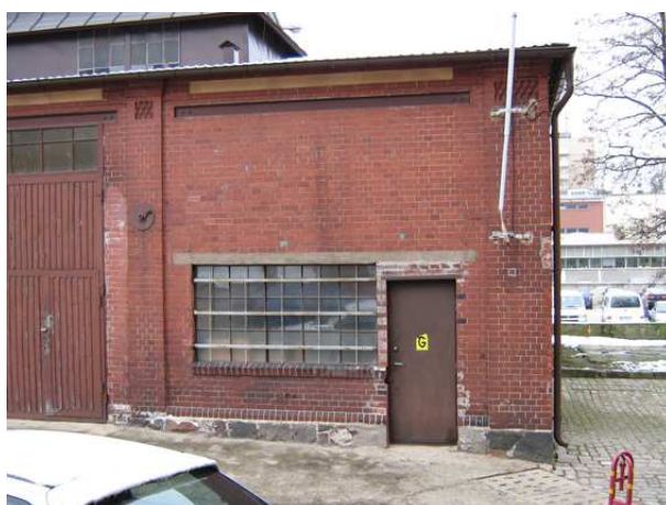
7. i 8. Fragmenty elewacji wschodniej – brama i wrota, widoczne zabrudzenia zaprawą po wstawieniu bramy, krata stalowa okna, lampa ze stalowym mocowaniem, ubytki cegieł oraz fragmenty farby nad obniżonym oknem.
