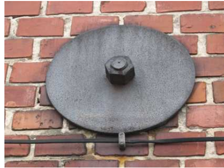
14. i 15. Elewacja zachodnia – zacieki pod stalowymi zakotwieniami ściągów i przewodu wentylacyjnego. Szczegół zakotwienia.
