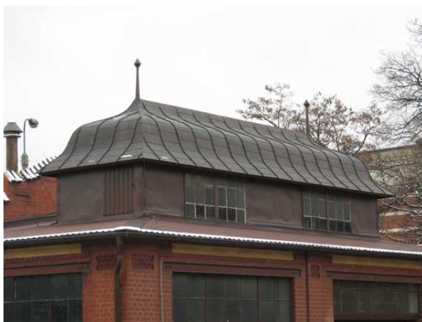
12. i 13. Dachówka mnich-mniszka na attyce ściany zachodniej, okna latarni, blacha trapezowa przykrywająca okno latarni, obróbka blacharska dachu przy attyce.
