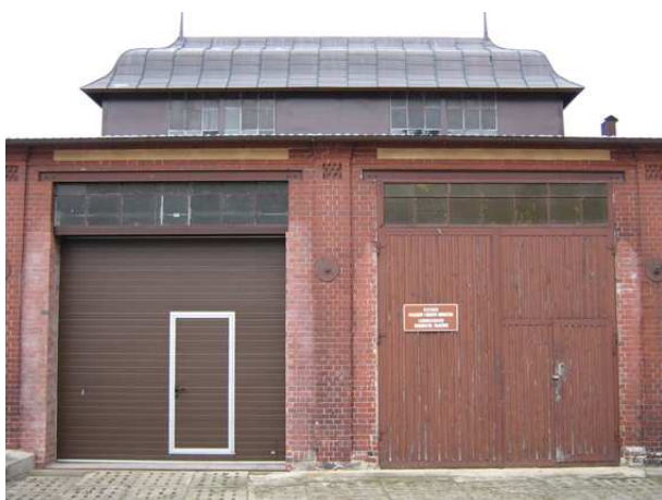
7. i 8. Fragmenty elewacji wschodniej – brama i wrota, widoczne zabrudzenia zaprawą po wstawieniu bramy, krata stalowa okna, lampa ze stalowym mocowaniem, ubytki cegieł oraz fragmenty farby nad obniżonym oknem.
